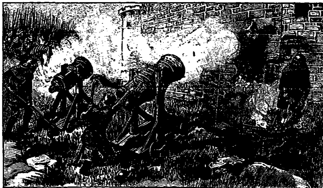
DES CANONS FONT UN TROU DANS LE MUR DU CHATEAU.
